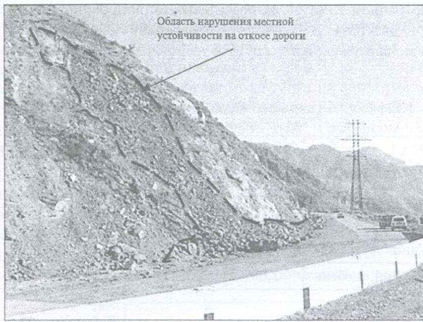
Рис. 3. Вид горной автомобильной дороги после зачистки осыпавшегося грунта в результате нарушения местной устойчивости откоса после выпадения осадков
